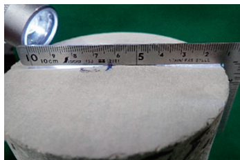
膨れたコンクリート
