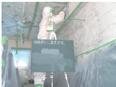
● 解体現場でのモニタリング状況（作業室内・除塵装置出口）
