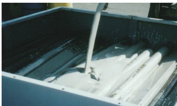
● プレミックスセメントの充填状況
