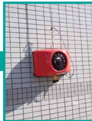
ウォールサーベイロボの走査状況と打診音を録画します。
