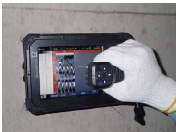
● 鉄筋探査状況
