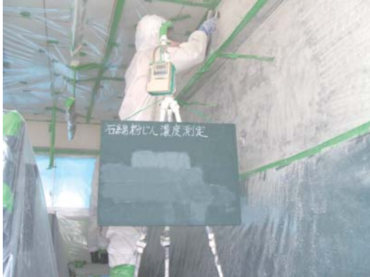
● 解体現場でのモニタリング状況
