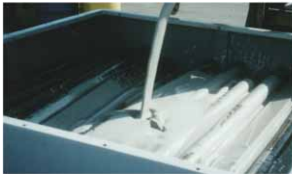
● プレミックスセメントの充填状況
