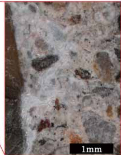
●チャートから滲出した白色ASRゲル
