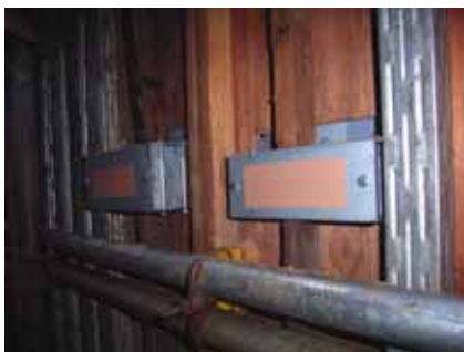
写真 1.1 ボス型枠の取付け状況
