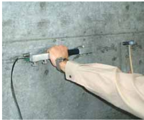
写真 5.1 振動検出器による壁の圧縮強度測定状況
